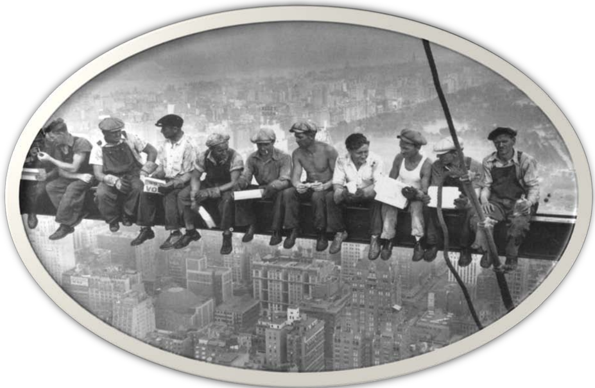
Slika broj 1 Radnici na gradilištu (slika preuzeta sa interneta)
